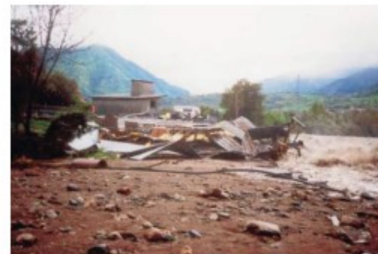
I resti del Centro Sociale dopo il passaggio dell'acqua nell'ottobre 2000
